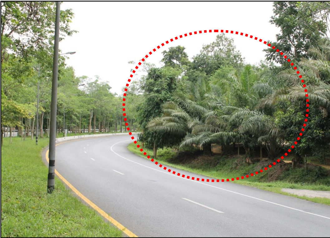
ต้นไม้บดบังระยะมองเห็นบริเวณทางโค้ง
